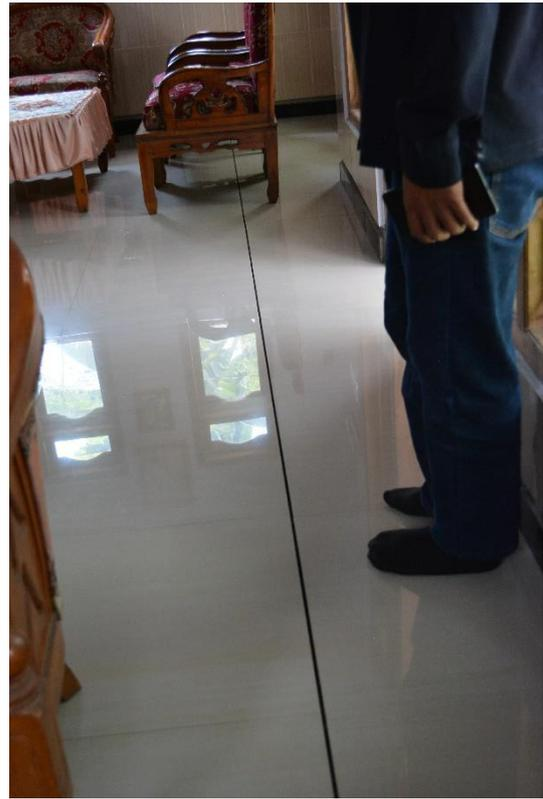
Gambar 4. Pergeseran pada lantai (terlihat dari jarak keramik yang berubah)
